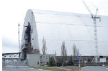
工事中的新シェルター (撮影：2015年11月、第6回調査)
