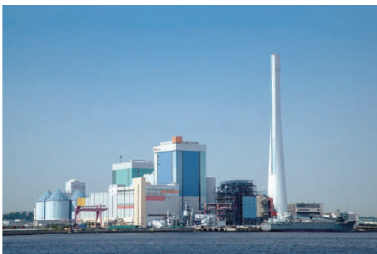
磯子火力発電所
